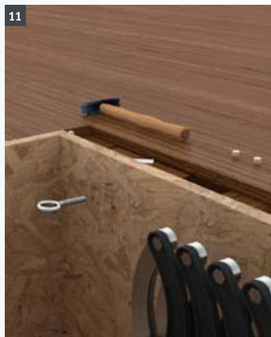
11 demontáž závěsných ok a zaslepení vzniklých otvorů zásepky
