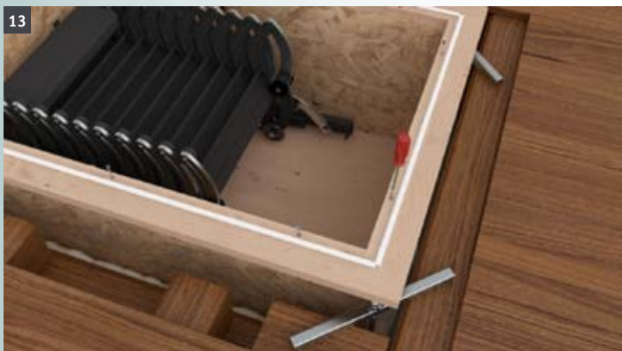
13 nasazení a přišroubování horního víka
