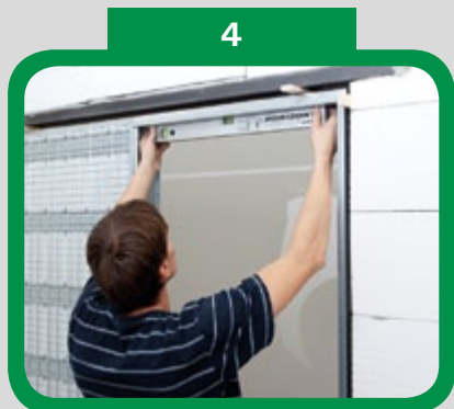
Vyvažte stavební pouzdro horizontálně a vertikálně
