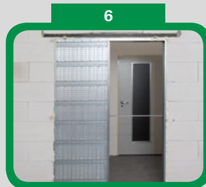
Zapěněné pouzdro ve stavebním otvoru
