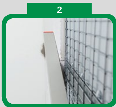
Vložte stavební pouzdro do stavebního otvoru
