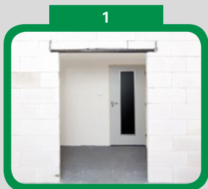
Připravený stavební otvor
